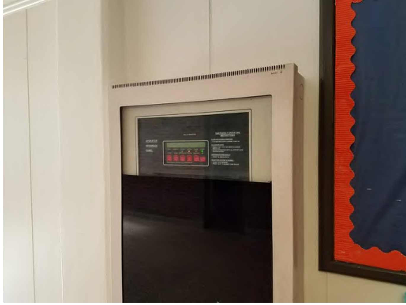
Fire Alarm Annunciator
